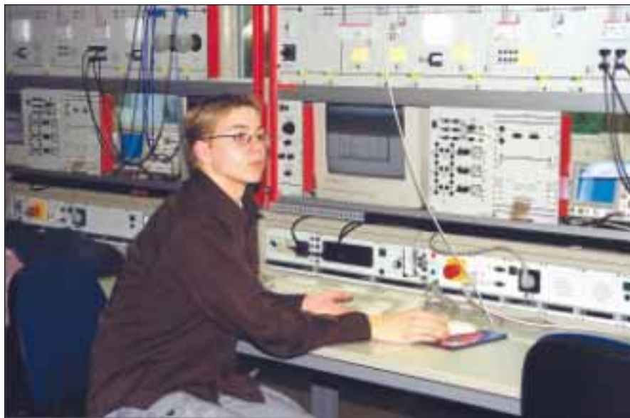
„Labor für Gebäudemanagement“: die Haustechnik wird computergestützt zentral gesteuert.
